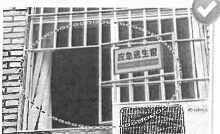
整改措施 设置外墙逃生窗
