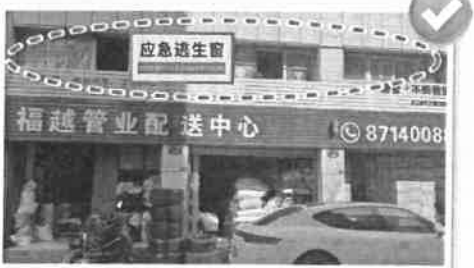
整改措施 拆除遮挡部分，留出逃生窗位置
