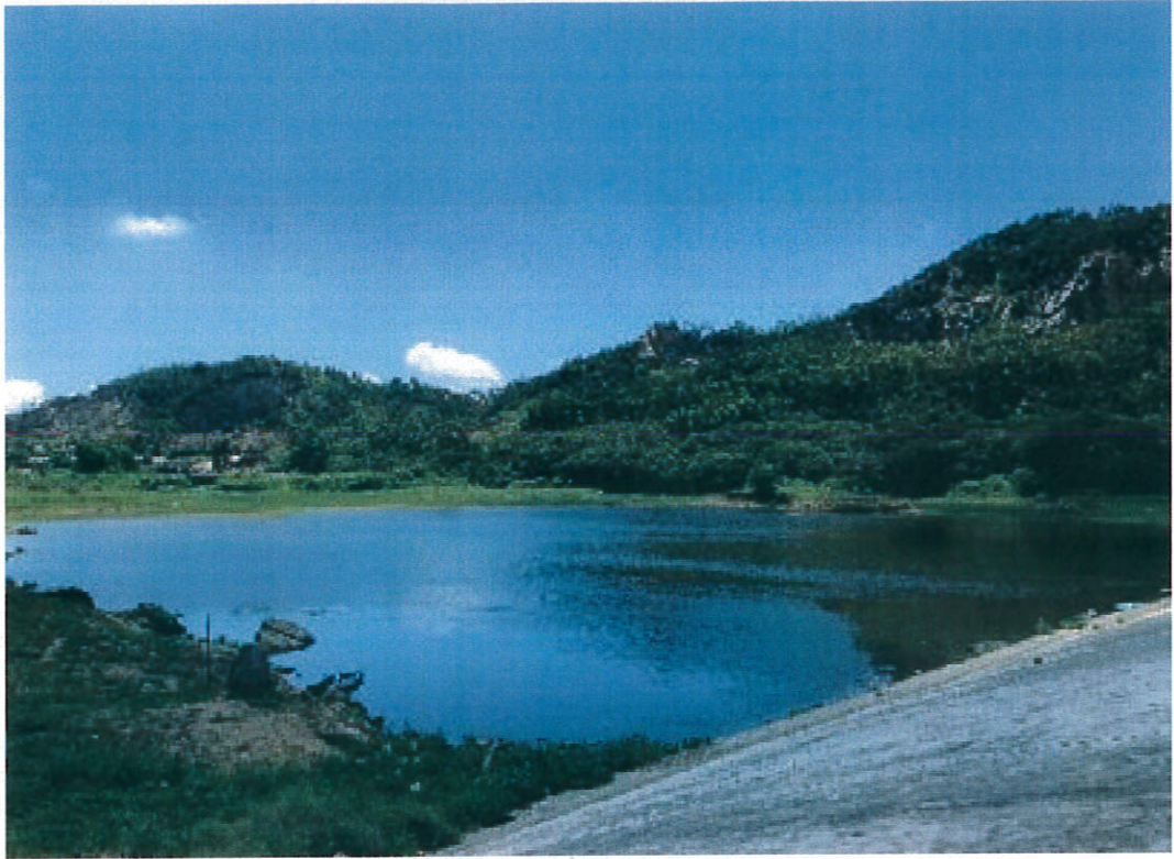
埔坑水库库区照片
