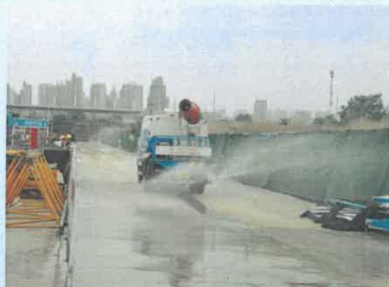
洒水车洒水降尘
