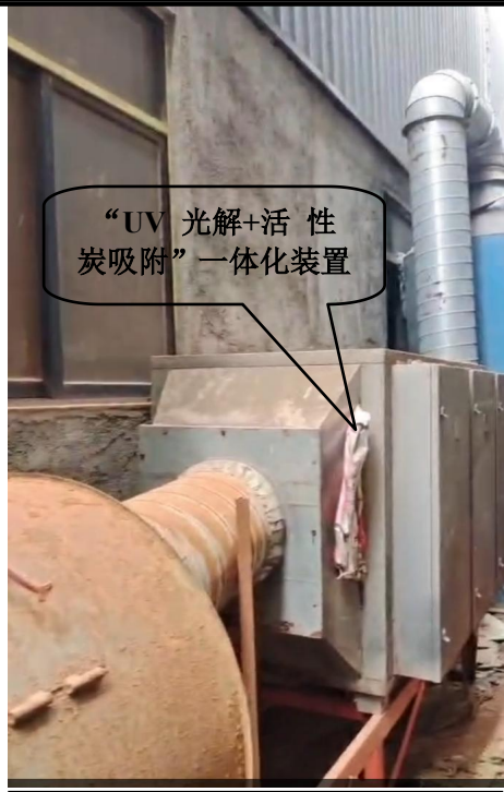
喷漆、烘干、喷粉固化废气处理设施 (DA002)
