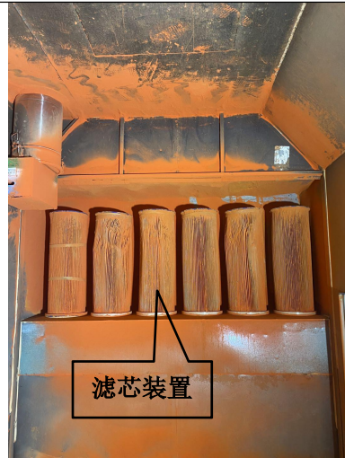
喷漆、烘干、喷粉固化废气处理设施 (DA002)
