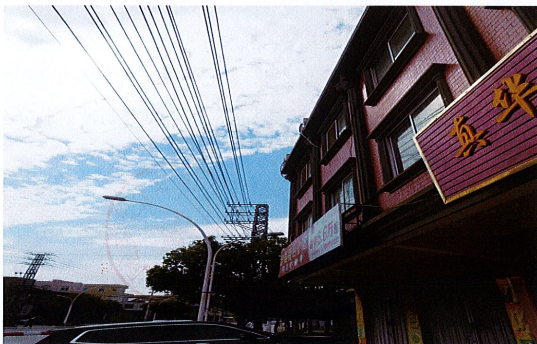
10 千伏东嘉线 34 杆至 35 杆与建筑物现场图片
