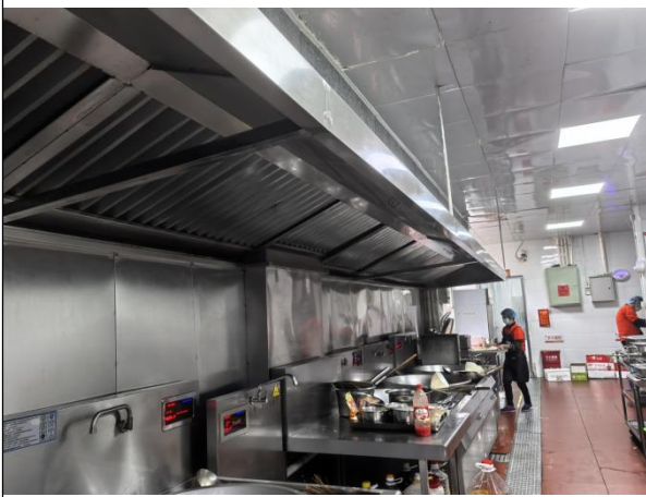
食堂油烟配套的集气罩及油烟净化器
