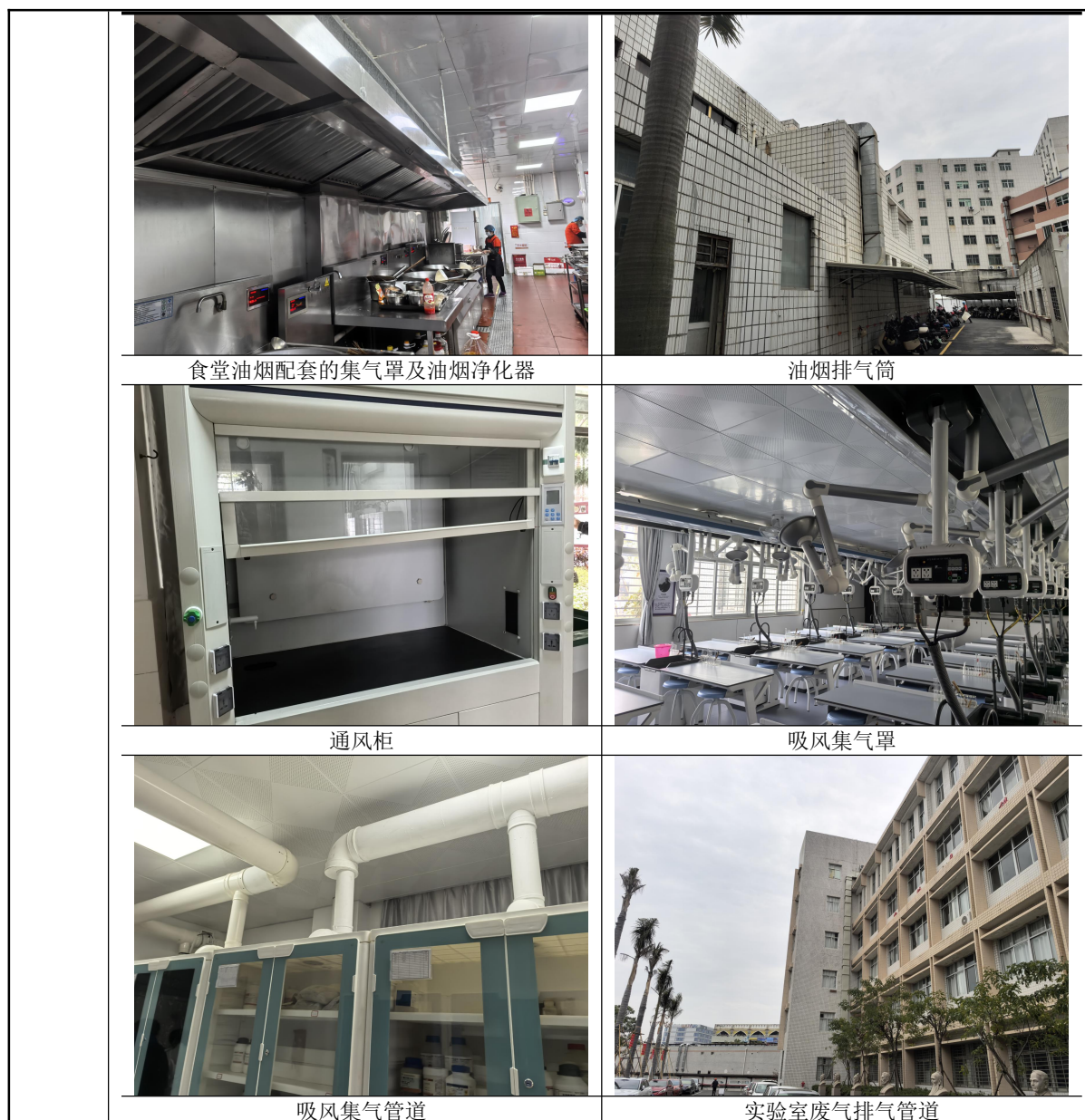
图 2-3 紫峰中学现有废气治理设施照片
